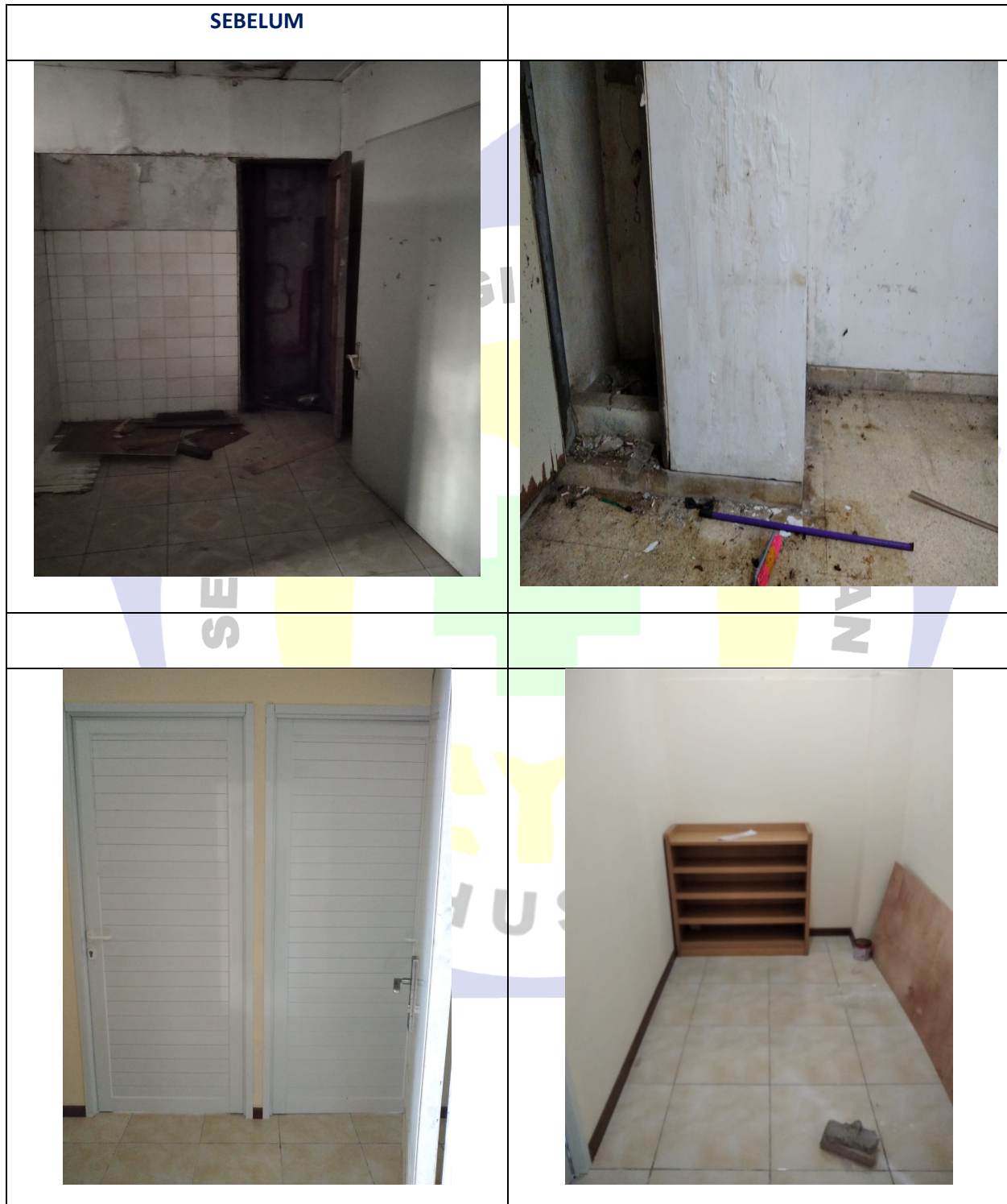
Gambar 3.9 RENAVASI TOILET LANTAI 5 KANAN MENJADI GUDANG IT DAN ALAT PBM Juli 2022
